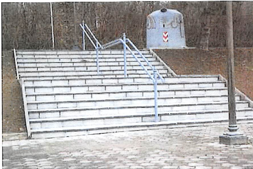
Slika 8: Sanacija glavnega stopnišča
