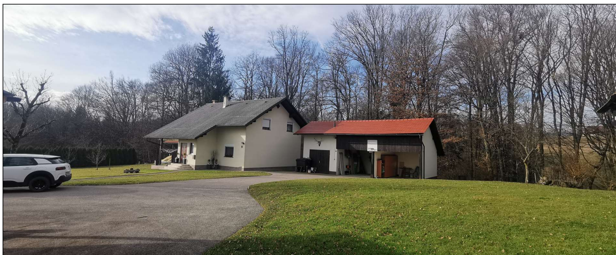
Slika 11: Pogled na obstoječi stanovanjski objekt z garažo
