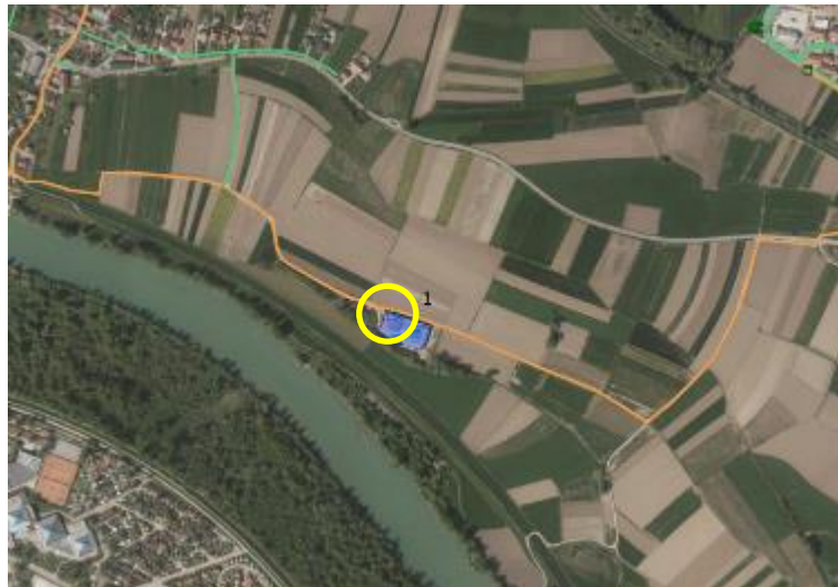
Slika 4: Zaključek kanalizacijskega sistema Brežice na čistilni napravi Brežice
