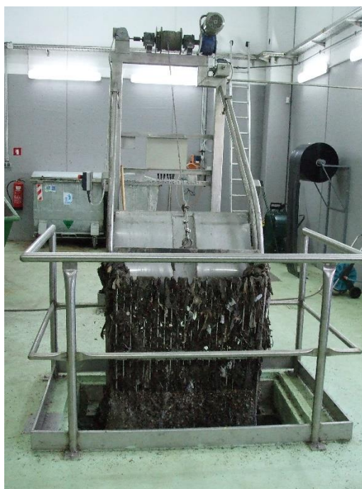
Slika 2: Grobe grablje na čistilni napravi
