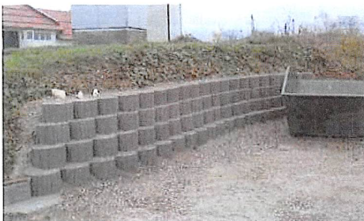
Slika 3: Ureditev podpornega zidu na ZRC Boršt
